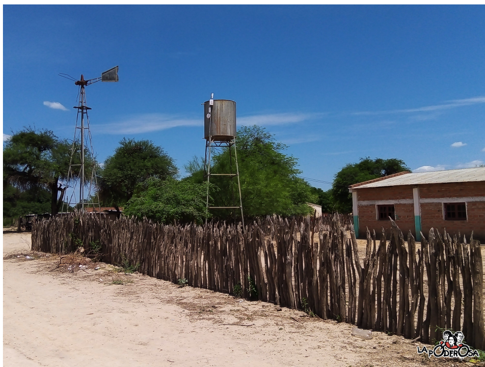
Ilustración 8: router instalado en tanque de agua de uno de los nodos de la red Misión Grande. Foto gentileza de La Poderosa.
